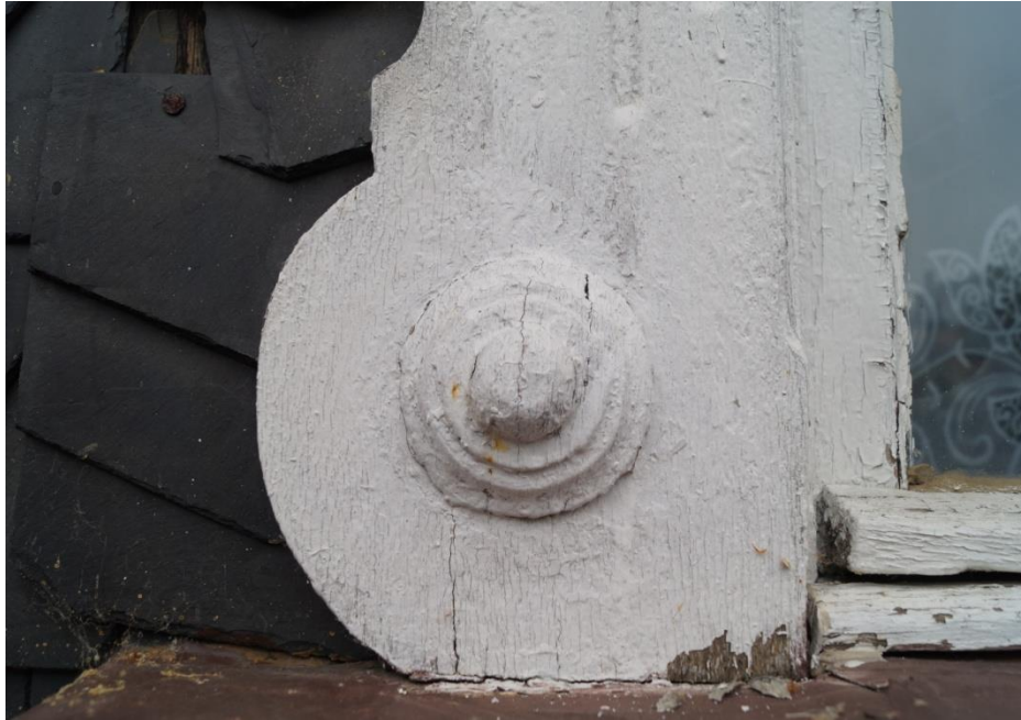
Fot. 57 (wyk. W. Tomaszewski): Detal opaski stolarki okiennej w postaci ślimacznic.
