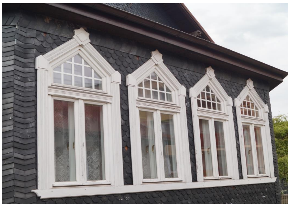
Fot. 64 (wyk. W. Tomaszewski): Współczesna stolarka okienna od strony południowej, wzorowana na oryginalnej. Okna wykonane z drewna sosnowego o konstrukcji skrzynkowej. Górna część zwieńczona trójkątnym oknem ze szprosami. Całość ujęta ozdobną opaską maskującą.
