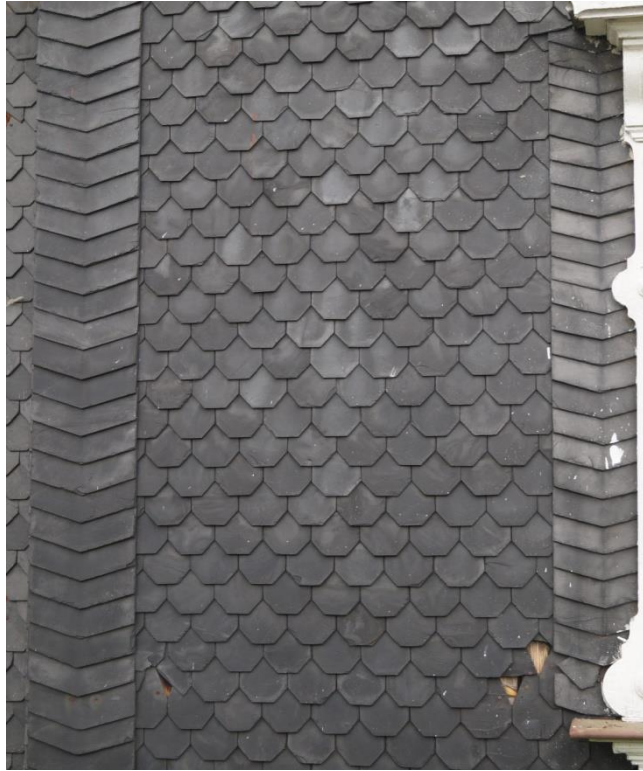
Fot. 4 (wyk. W. Tomaszewski): Elewacja zachodnia układ i kształt łupka węglowego na ścianie. Widoczne jest zróżnicowanie kształtów okładziny na narożnikach ryzalitu względem powierzchni ścian.
