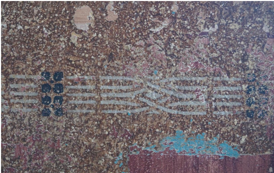
Fot. 116 (wyk. W. Tomaszewski): Zbliżenie wykonanej odkrywki stratygraficznej, ukazującej wybrany fragment oryginalnej lamperii z dekoracyjnym motywem ornamentalnym.
