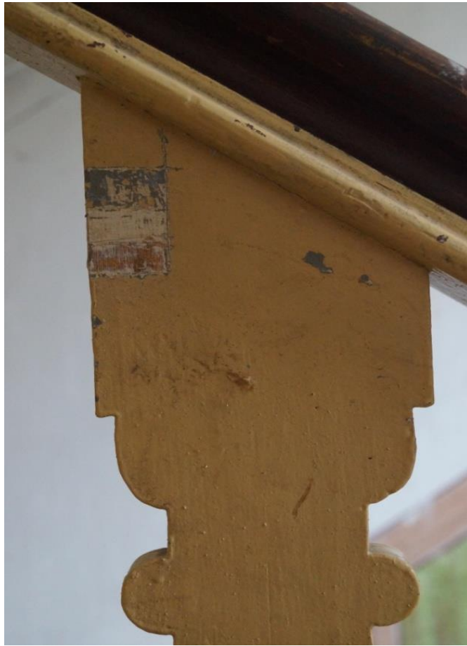
Fot. 106 (wyk. W. Tomaszewski): Odkrywka stratygraficzna na tralce.
