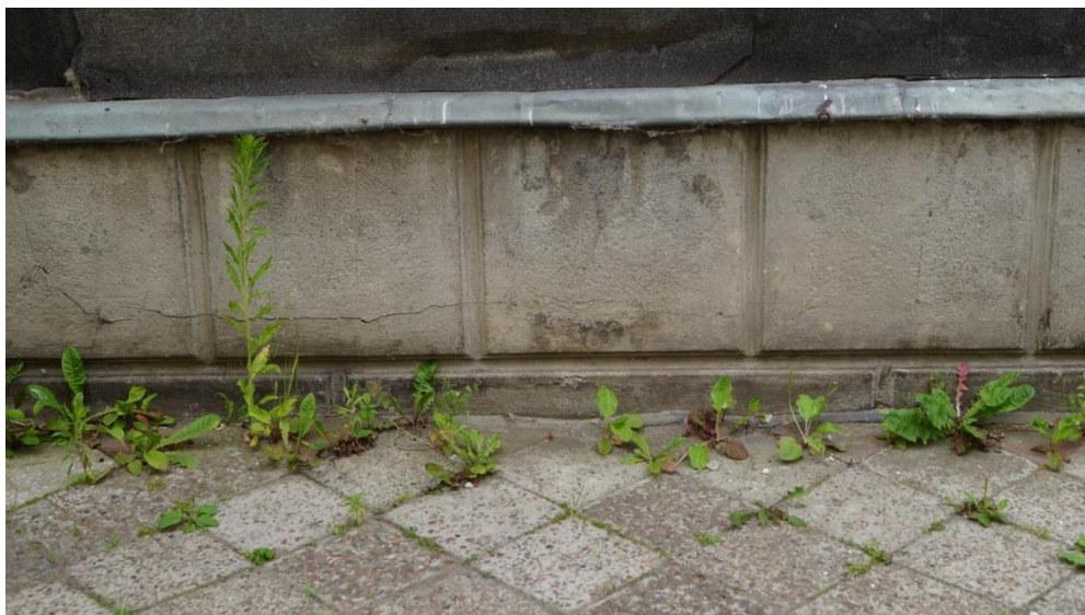
Fot. 22 (wyk. W. Tomaszewski): Boniowanie swą formą nawiązuje do bloków kamiennych.
