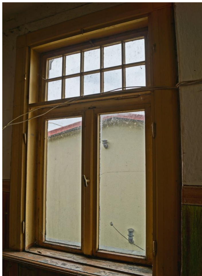
Fot. 61 (wyk. W. Tomaszewski): Stolarka okienna od strony wewnętrznej.
