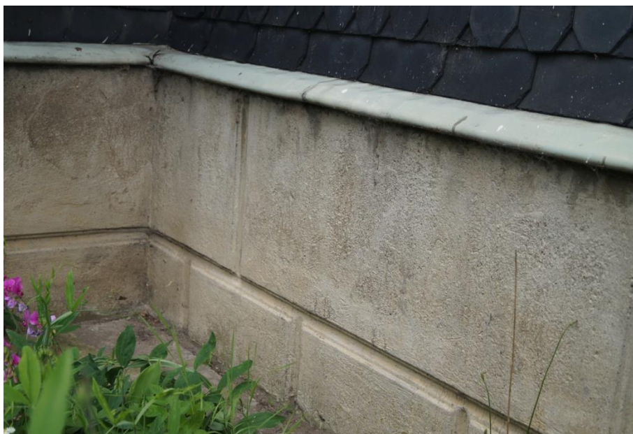
Fot. 2 (wyk. W. Tomaszewski): Podmurówka z boniowaniami o kształcie prostokątów wykonanych w tynku metodą ciągnioną. Oryginalnie tynk nie był malowany, gdyż pierwotny kolor tynku w całej jego masie był zbliżony do koloru jasnego piaskowca. Boniowania na ścianie frontowej są zachowane w bardzo dobrym stanie.
