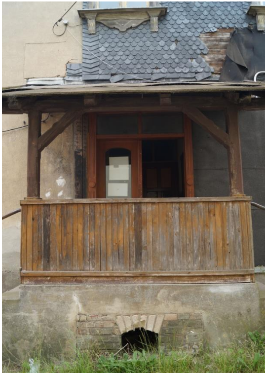
Fot. 8 (wyk. W. Tomaszewski): Ganek o konstrukcji drewnianej, prowadzący do głównego wejścia budynku. Słupy (fazowane na rantach) z zastrzałami wspierają dach pulpitowy kryty dachówką. Do ganku z ulicy prowadzą lustrzane betonowe schody.
