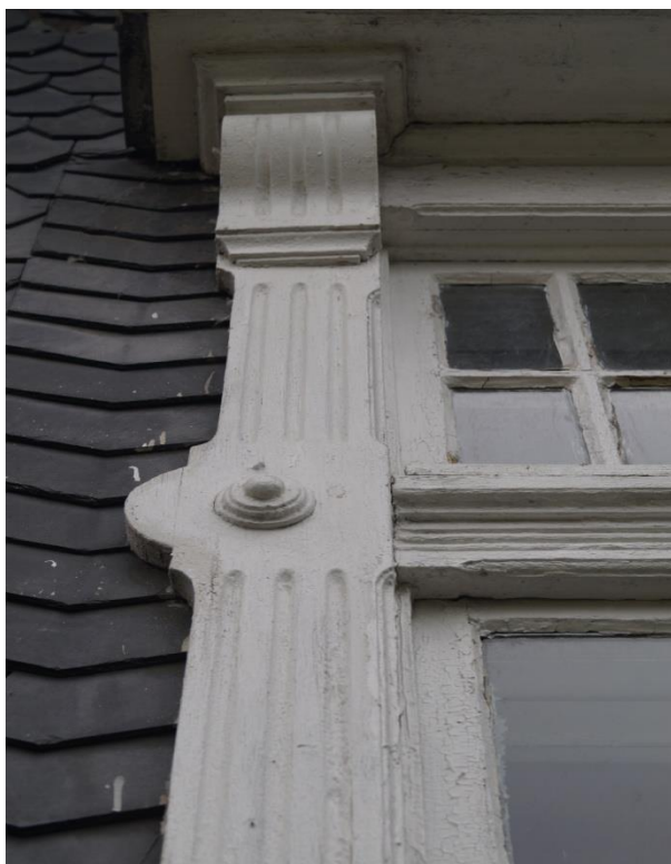
Fot. 53 (wyk. W. Tomaszewski): Fragmenty detalu bogato zdobionej opaski okiennej. Widoczne kanelury, wspornik i fragment zdobionego śłemia.
