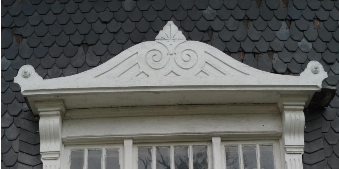
Fot. 51 (wyk. W. Tomaszewski): Fragment górnej opaski okiennej w postaci bogato zdobionego zwieńczenia z motywem roślinnym, wspartej na klasycyzujących wspornikach.
