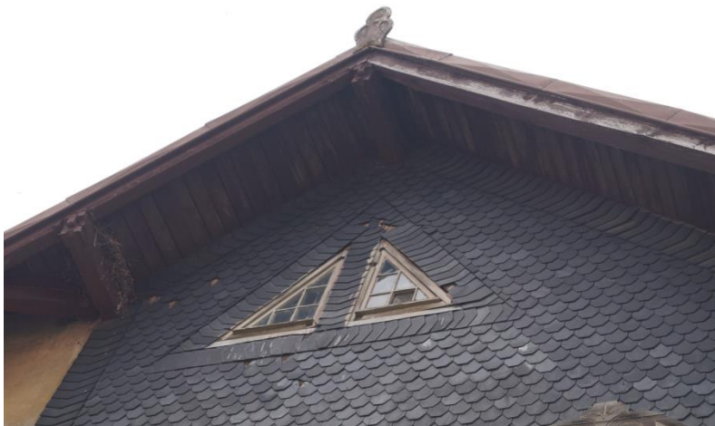
Fot. 9 wyk. W. Tomaszewski): Szczyt z trójkątnymi oknami i mały dekoracyjny pazdur na kalenicy. Na elewacji widoczne zróżnicowanie w kształtach okładziny.
