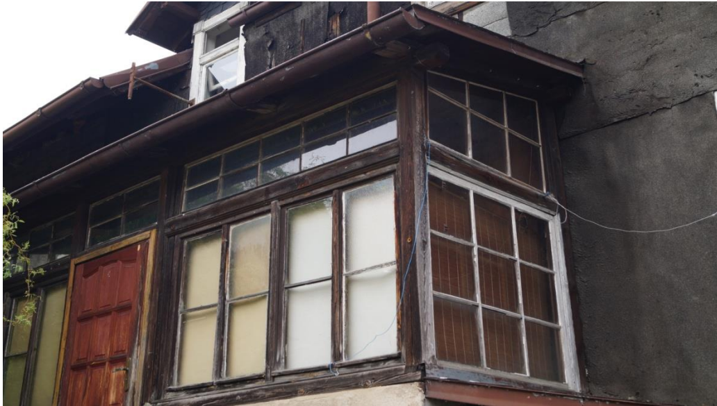
Fot. 78 (wyk. W. Tomaszewski): Stolarka okienna werandy jest wykonana z drewna sosnowego o konstrukcji krosnowej z pojedynczymi szczeblinami. Świetliki o konstrukcji ramowej, stałe.
