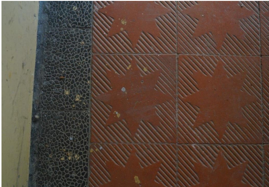
Fot. 96 i 97 (wyk. mgr W. Tomaszewski): Oryginalna posadzka klatki schodowej wyłożona kaflami z kamionki. Mogą to być kafle produkcji niemieckiej z firmy Otto Kaufmann lub Villeroy Bosch.
