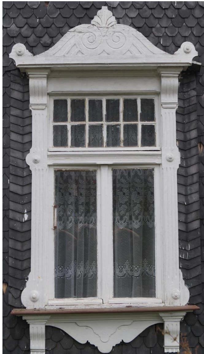
Fot. 59 (wyk. W. Tomaszewski): Stolarka okienna o konstrukcji skrzynkowej wykonana z drewna sosnowego, trójdzielna ze ślemieniem i listwą przymykową . Górne skrzydła okienne o kształcie leżącego prostokąta ze szkleniem w szprosach. Dolne skrzydła okienne o kształcie stojącego prostokąta szklenie bez podziałów. Całość ujęta ozdobną opaską maskującą z bogatym detalem snycerskim.
