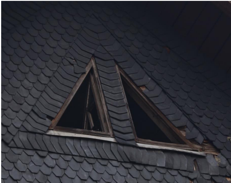
Fot. 75 (wyk. W. Tomaszewski): Stolarka okienna poddasza od strony północnej. Konstrukcja krosnowa z drewna sosnowego w kształcie trójkąta ze szczelinami .
