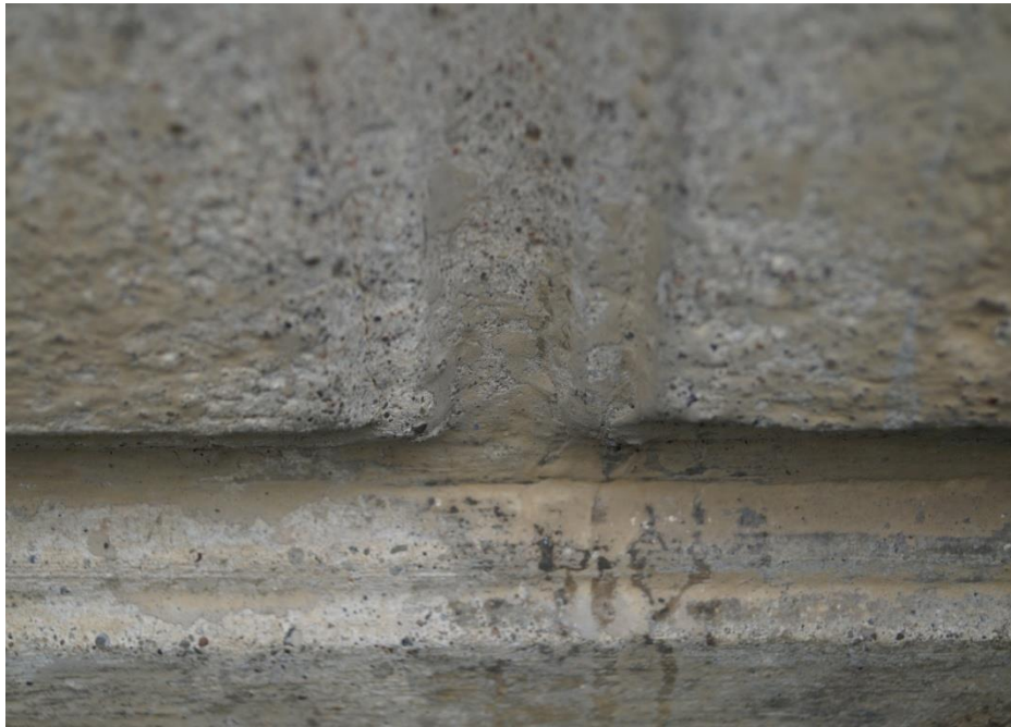
Fot. 23 (wyk. W. Tomaszewski): Ciągiony ozdobny profil boniowania nawiązuje do ozdobnie profilowanych bloków kamiennych
