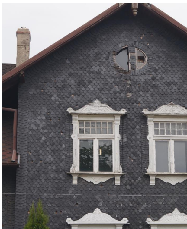
Fot. 3 (wyk. W. Tomaszewski): Elewacja frontowa. Widoczne jest zróżnicowanie w formie oraz układzie łupka względem narożników a płaską powierzchnią ścian. Zachowana stolarka okienna z bogato dekorowaną opaską. Na szczycie widoczny okulus.
