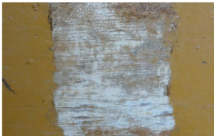
Fot. 105 (wyk. W. Tomaszewski): Oryginalnie schody pomalowane były na kolor zbliżony do: NCS S-0500N
