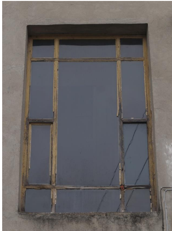
Fot. 68 (wyk. W. Tomaszewski): Stolarka okienna klatki schodowej od strony wschodniej. Konstrukcja ramowa pojedyncza ze szkleniem na stałe jedynie otwieranymi lufcikami, wykonana z drewna sosnowego. Bardzo możliwe że pierwotnie szklenie było kolorowe.
