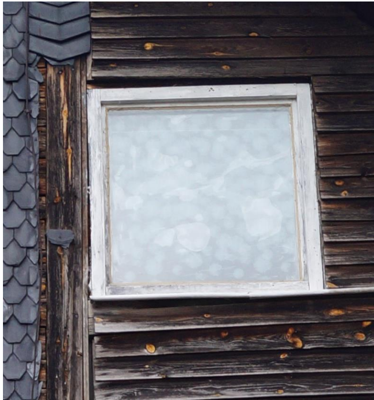
Fot. 80 (wyk. W. Tomaszewski): Wtórna stolarka okienna – piętro od strony południowej.
