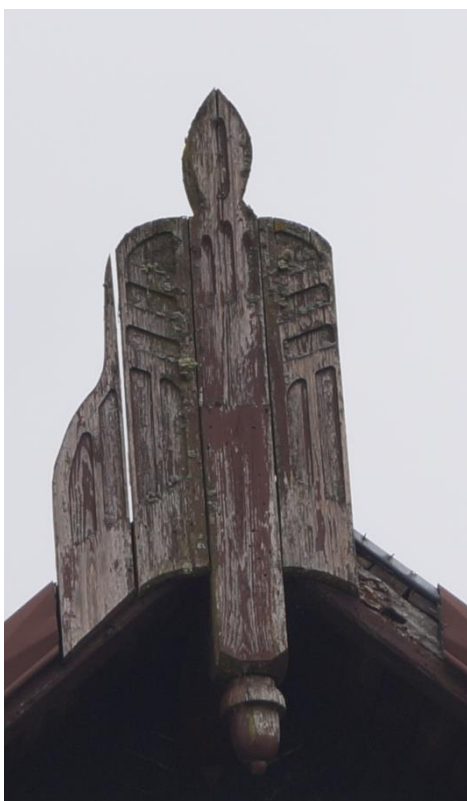
Fot. 47 (wyk. mgr W. Tomaszewski): Ozdobny drewniany pazdur na kalenicy dachu od strony zachodniej.
