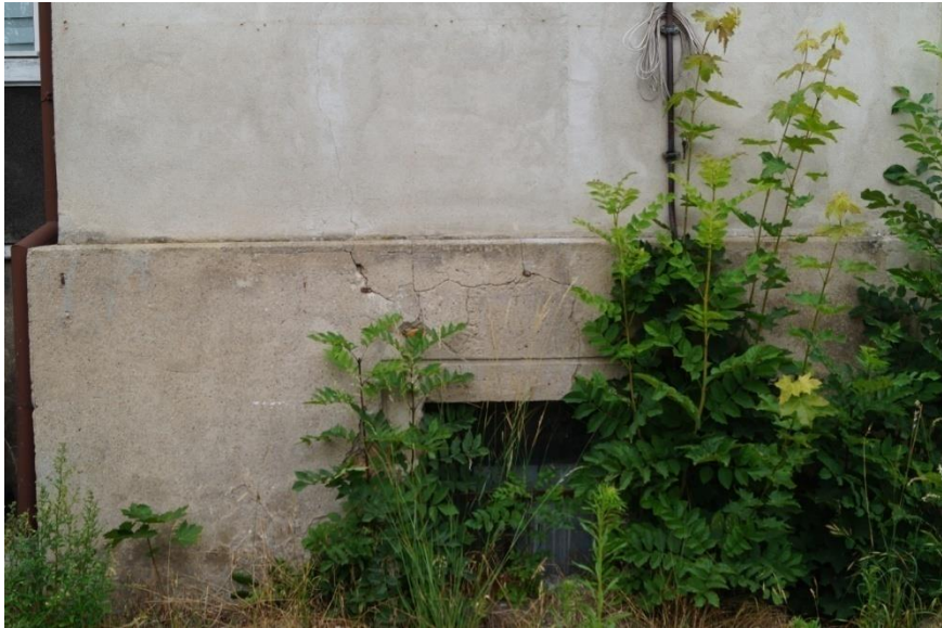
Fot. 19 (wyk. W. Tomaszewski) Cokół klatki schodowej otynkowany z ozdobnym ryflowanym paskiem wokół okna piwnicznego. Powyżej wtórny/współczesny tynk zatarty na gładko.
