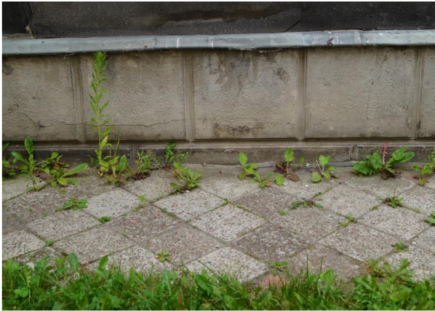
Fot. 7 (wyk. W. Tomaszewski): Podmurówka z boniowaniami o kształcie prostokątów, wykonanych w tynku metodą ciągnioną. Oryginalnie tynk nie był malowany, gdyż pierwotny kolor tynku w całej jego masie był zbliżony do koloru jasnego piaskowca. Boniowania na ścianie frontowej są zachowane w bardzo dobrym stanie.
