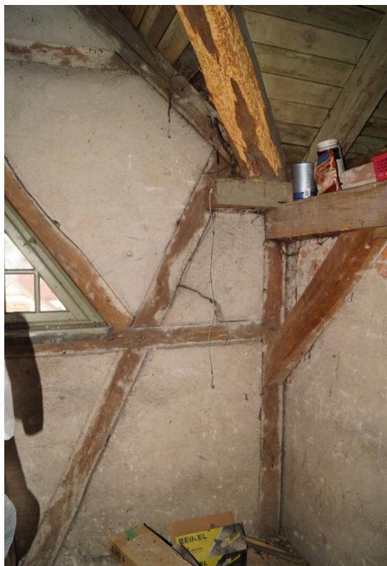
Fot. 34 i 35 (wyk.: W. Tomaszewski): Konstrukcja szkieletowa budynku od strony poddasza.
