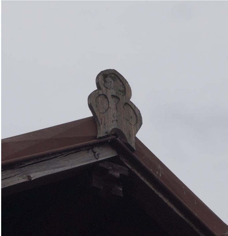
Fot. 48 (wyk. mgr W. Tomaszewski): Ozdobny drewniany pazdur na kalenicy wykuszu dachowego.
