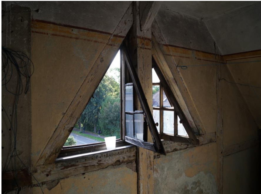
Fot. 76 (wyk. W. Tomaszewski): Widok od strony wewnętrznej. Widoczne jest osadzenie pomiędzy belkami szkieletu konstrukcji budynku.
