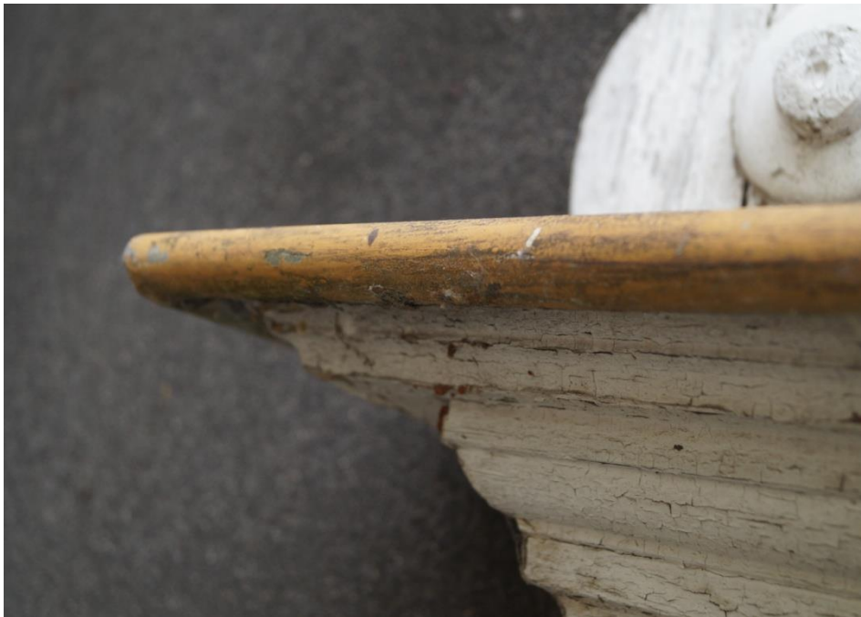
Fot. 58 (wyk. W. Tomaszewski): Oryginalne opierzenie drewnianego parapetu blachą cynkową.
