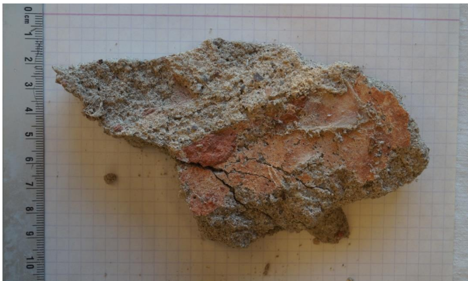
Fot. 27 (wyk.: W. Tomaszewski): Próbką tynku zatartego na gładko, pobrana z płaskiej powierzchni ściany przybudówki/klatki schodowej. Jest to klasyczny lekki i porowaty tynk cementowo-wapienny, dodatkiem piasku kwarcowego (żwir rzeczny) o frakcji od: 0,5mm do: 4mm.
