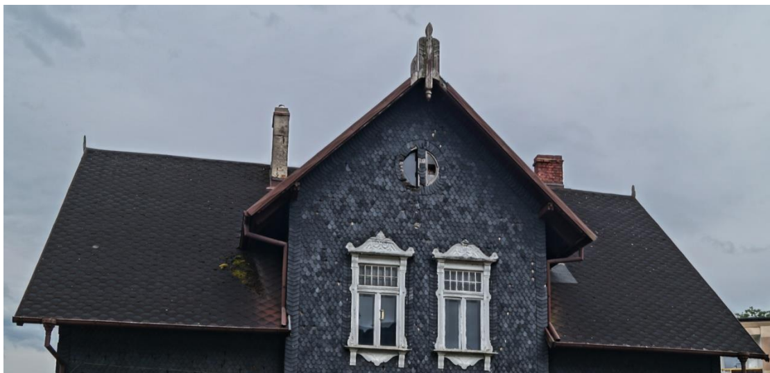
Fot. 42 (wyk. mgr W. Tomaszewski): Widok ogólny na dach od strony zachodniej. Dach jest drewniany o konstrukcji płatwiowo-kleszczowej i pokryta deskowaniem, na które pierwotnie nałożona była dachówka ceramiczna.
