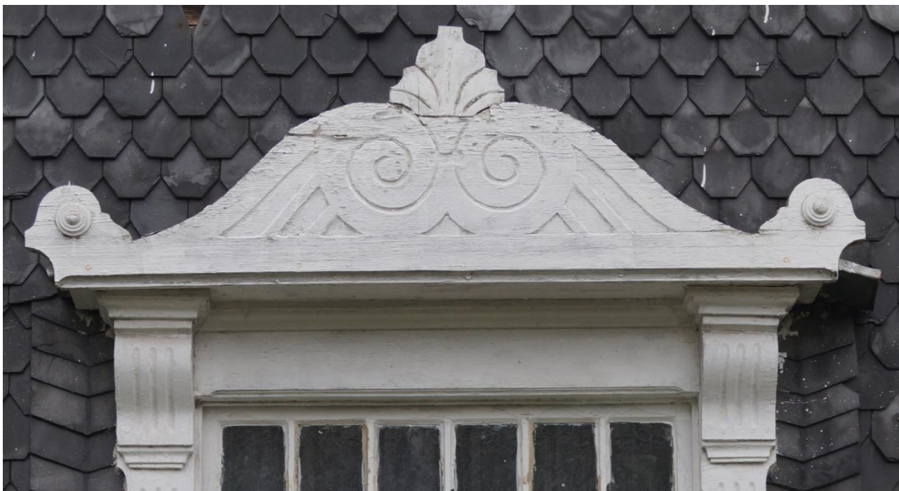
Fot. 60 (wyk. W. Tomaszewski): Fragment górnej opaski okiennej w postaci bogato zdobionego zwieńczenia z motywem roślinnym, wspartej na klasycyzujących wspornikach.
