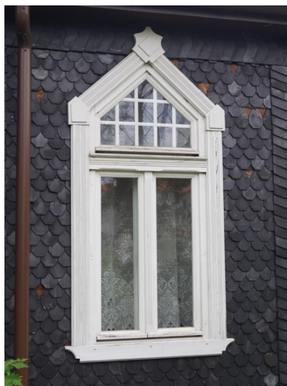
Fot.65 (wyk.W.Tomaszewski): Współczesna stolarka okienna od strony południowej, wzorowana na oryginalnej.
