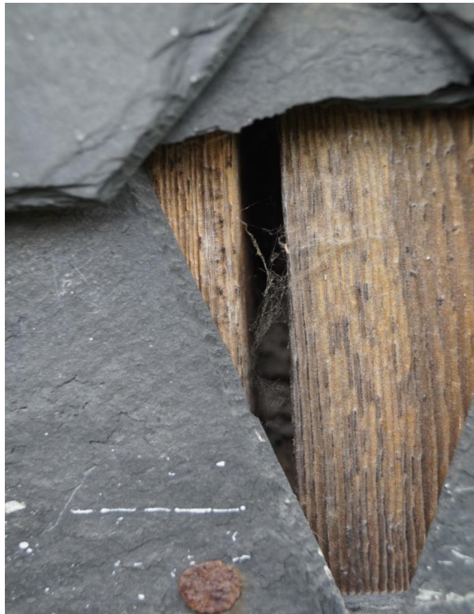
Fot. 33 (wyk.: W. Tomaszewski): Widoczne deskowanie i fragment zaprawy murarskiej.
