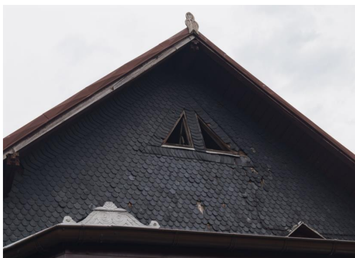
Fot. 14 (wyk. W. Tomaszewski): Zwieńczenie elewacji południowej z trójkątną stolarką okienną i małym drewnianym pazdurem na kalenicy.
