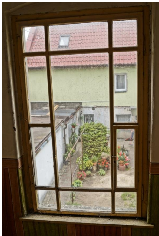
Fot. 69 (wyk. W. Tomaszewski): Stolarka okienna od strony wnętrza. Widoczne otwierane do wnętrza lufciki .
