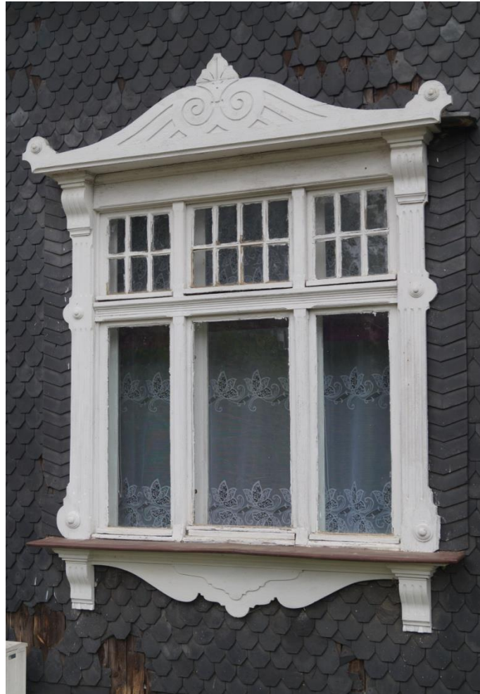
Fot. 50 (wyk. W. Tomaszewski): Stolarka okienna o konstrukcji skrzynkowej wykonana z drewna sosnowego, 6-dzielna ze ślimieniem i słupkami. Górne skrzydła okienne o kształcie prostokąta i kwadratów ze szkleniem w szprosach. Dolne skrzydła okienne o kształcie stojącego prostokąta (szklenie bez podziałów). Całość ujęta ozdobną opaską maskującą z bogatym detalem snycerskim.
