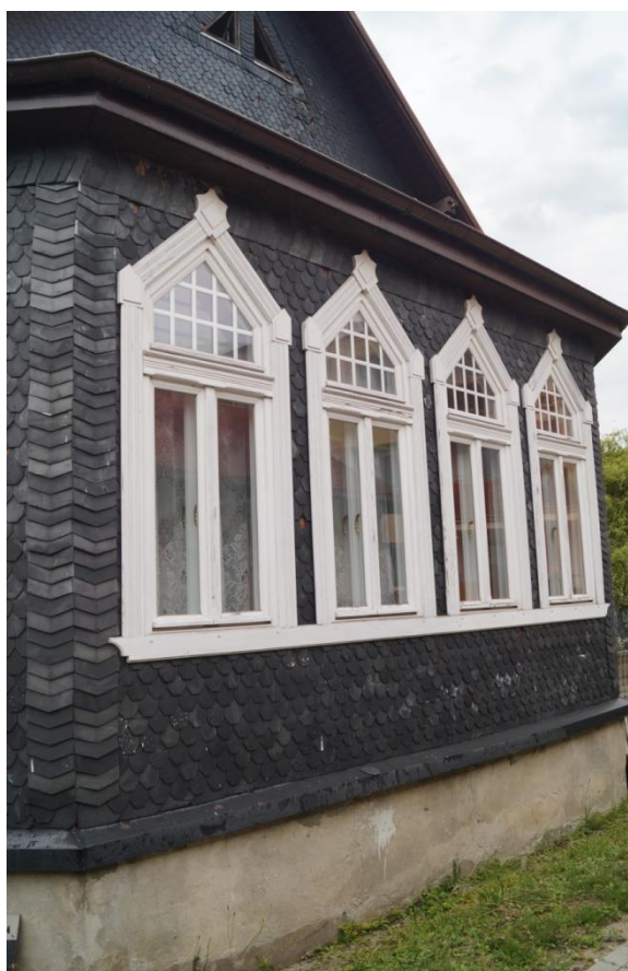
Fot. 15 (wyk. W. Tomaszewski): Współczesne/wtórne okna werandy, wzorowane na oryginalnej stolarce okiennej. Cokół jest pokryty nową warstwą tynku z widocznymi pozostałościami po boniowaniach.
