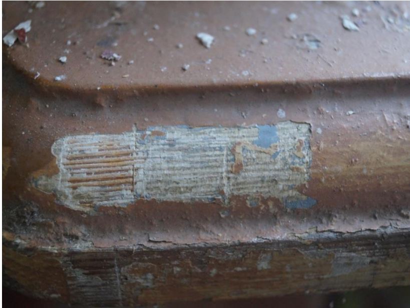
Fot. 84 (wyk. W. Tomaszewski): Stratygrafia kolorystyczna – parapet okienny od strony wnętrza.
