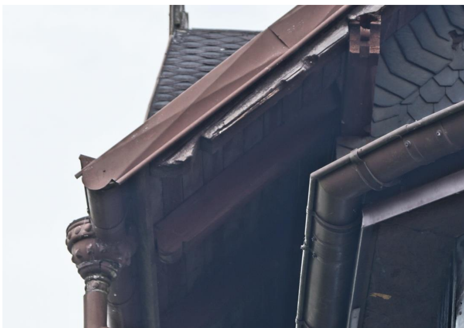
Fot. 45 (wyk. mgr W. Tomaszewski): Zachowany kosz rynnowy o dekoracyjnej formie. Widoczne jest ozdobne zakończenie murłaty wychodzącej poza obrys konstrukcji ściany.
