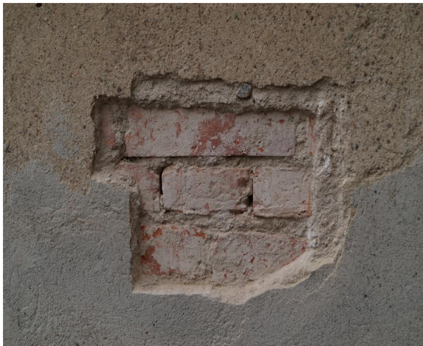
Fot. 26 (wyk.: W. Tomaszewski): Podmurówka budynku jest wykonana z cegły na zaprawie cementowo-wapiennej, otynkowana w formie boniowania lub zatarta na gładko na powierzchniach ścian dobudowanej klatki schodowej.
