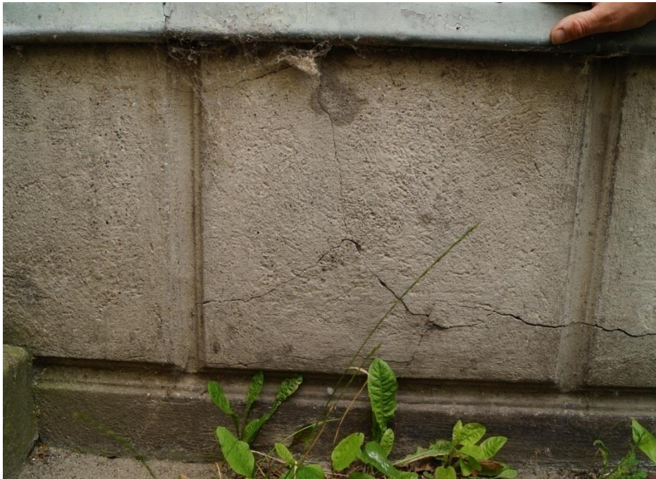
Fot. 21 (wyk. W. Tomaszewski): Podmurówka budynku wykonana z cegły otynkowana zaprawą z cementu romańskiego w formie boniowań. Pierwotnie powierzchnia boniowań nie była malowana, tynk kolorystycznie nawiązywał do jasnego piaskowca.
