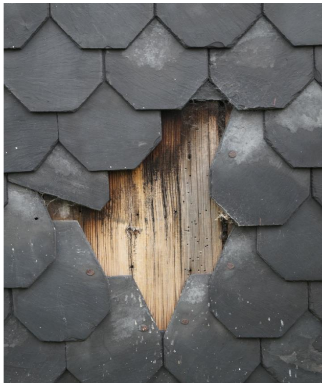
Widoczny fragment deskowania pokryty łupkiem węglowym.
