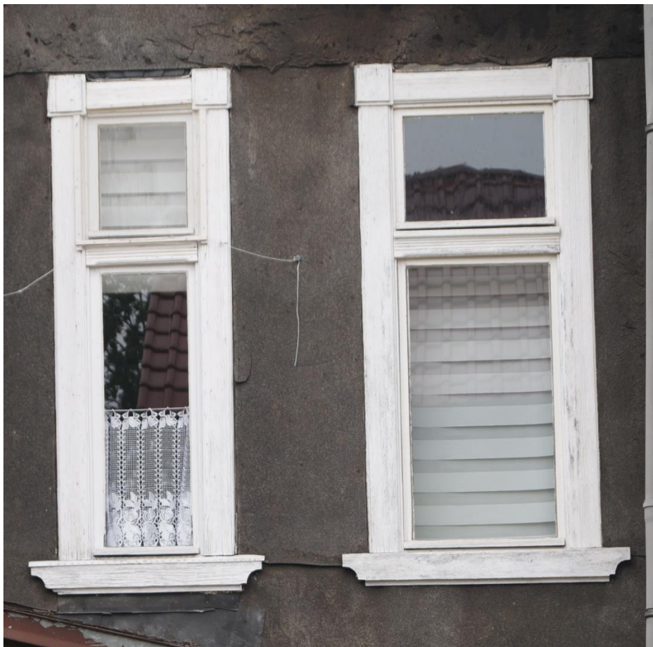
Fot. 71 (wyk. W. Tomaszewski): Stolarka okienna od strony wschodniej o konstrukcji krosnowej wykonane z drewna sosnowego w kształcie stojących prostokątów z dekorowanym śłemeniem i ozdobną opaską maskującą.
