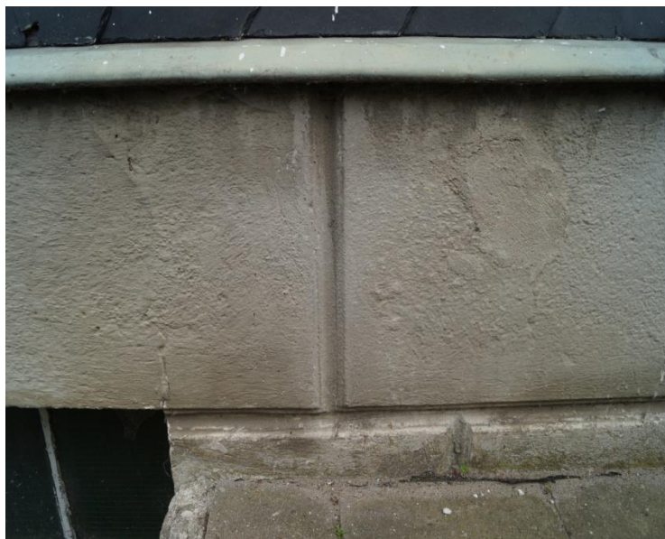
Fot. 12 (wyk. W. Tomaszewski): Podmurówka z boniowaniami o kształcie prostokątów, wykonanych w tynku metodą ciągnioną. Oryginalnie tynk nie był malowany, gdyż pierwotny kolor tynku w całej jego masie był zbliżony do koloru jasnego piaskowca. Boniowania na ścianie frontowej są zachowane w bardzo dobrym stanie.
