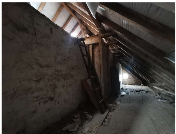
Ściany lokalu nr 3
