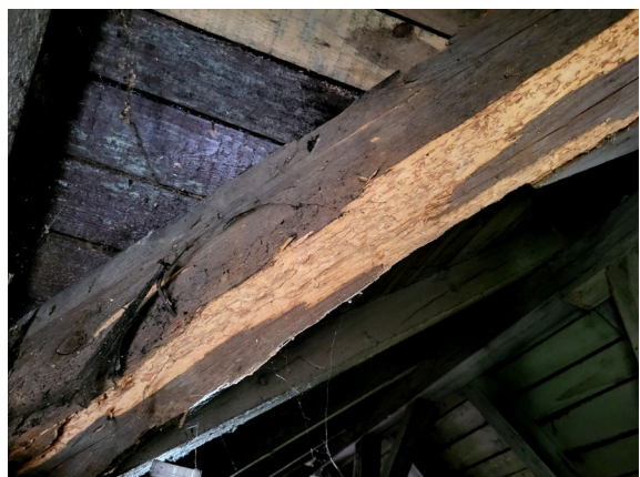
Fot. 10 Widok jak na fot. 9 -zbliżenie.
