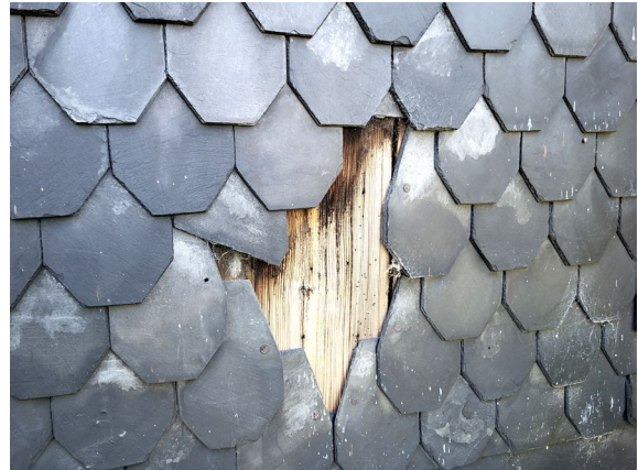
Fot. 26 Licowanie elewacji lupkiem naturalnym należy odtworzyć po wymianie deskowania i wykonaniu termomodernizacji budynku.
