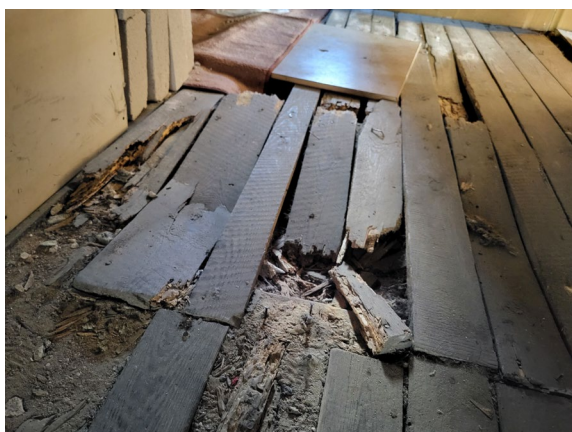
Fot. 3 Widok podłogi przy wejściu do pomieszczenia strychu.
