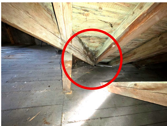
Fot. 15 Widok oparcia krokwi koszowej (str. pln-wsch).
