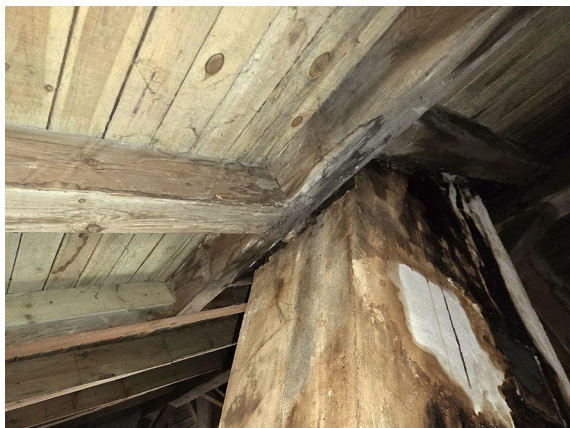
Fot. 17 Wymian kominowy od strony płu-wsch w stanie kwalifikującym się do wymiany.
