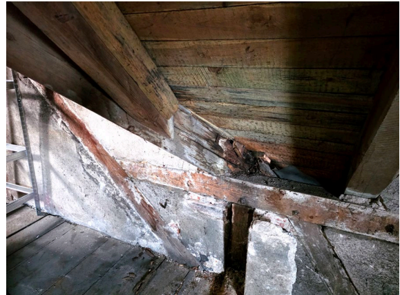
Fot. 14 Widok oparcia krokwi koszowej (str. pln-zach) na ścianie kolankowej.
