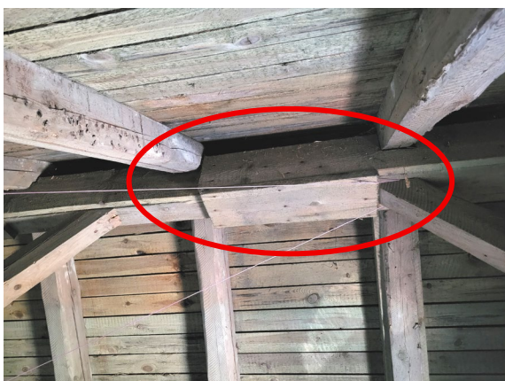
Fot. 19 Sztukowanie belki kalenicowej.
