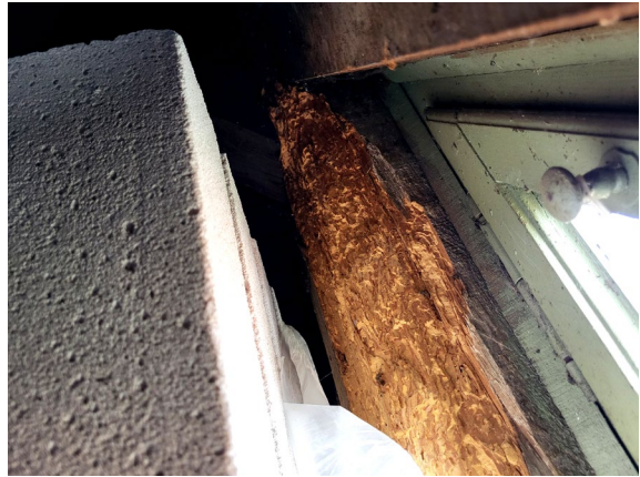
Fot. 8 Fragment słupa podtrzymującego kalenicę w osi wschodniej ściany szczytowej.
