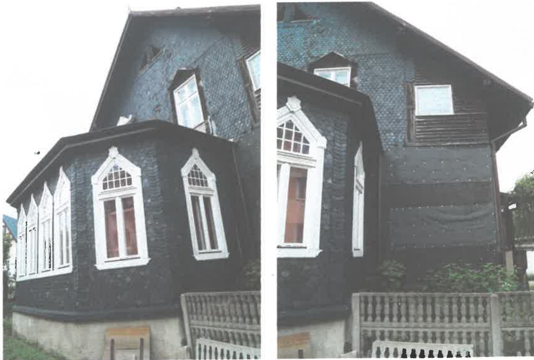
Fragment elewacji bocznej II – południowej
