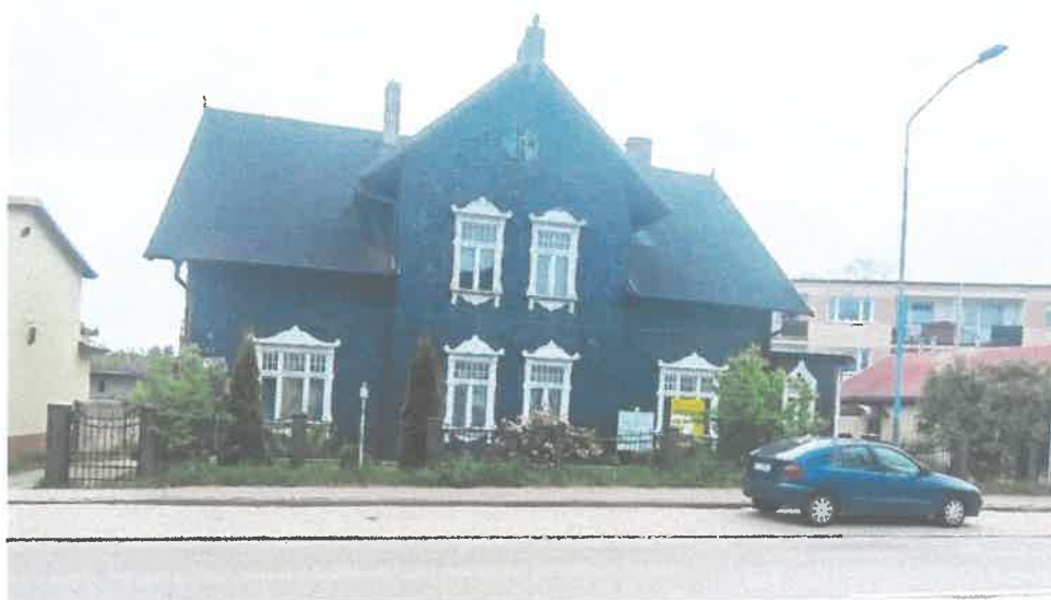
Elewacja frontowa – zachodnia
